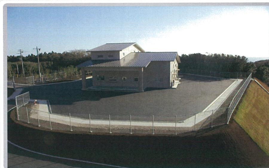
管理棟(水処理施設)
