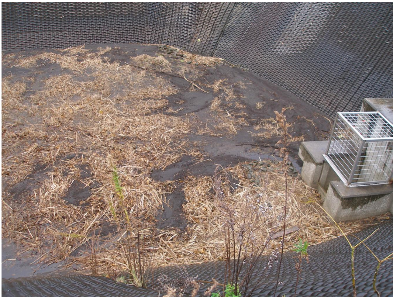
浚渫前の防災調整池の様子
