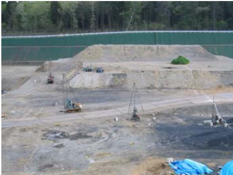
電極設置状況 (ボーリング状況)
