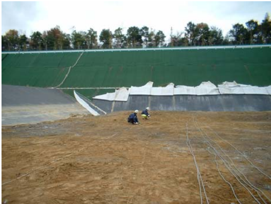
電極・電極ケーブル設置状況
