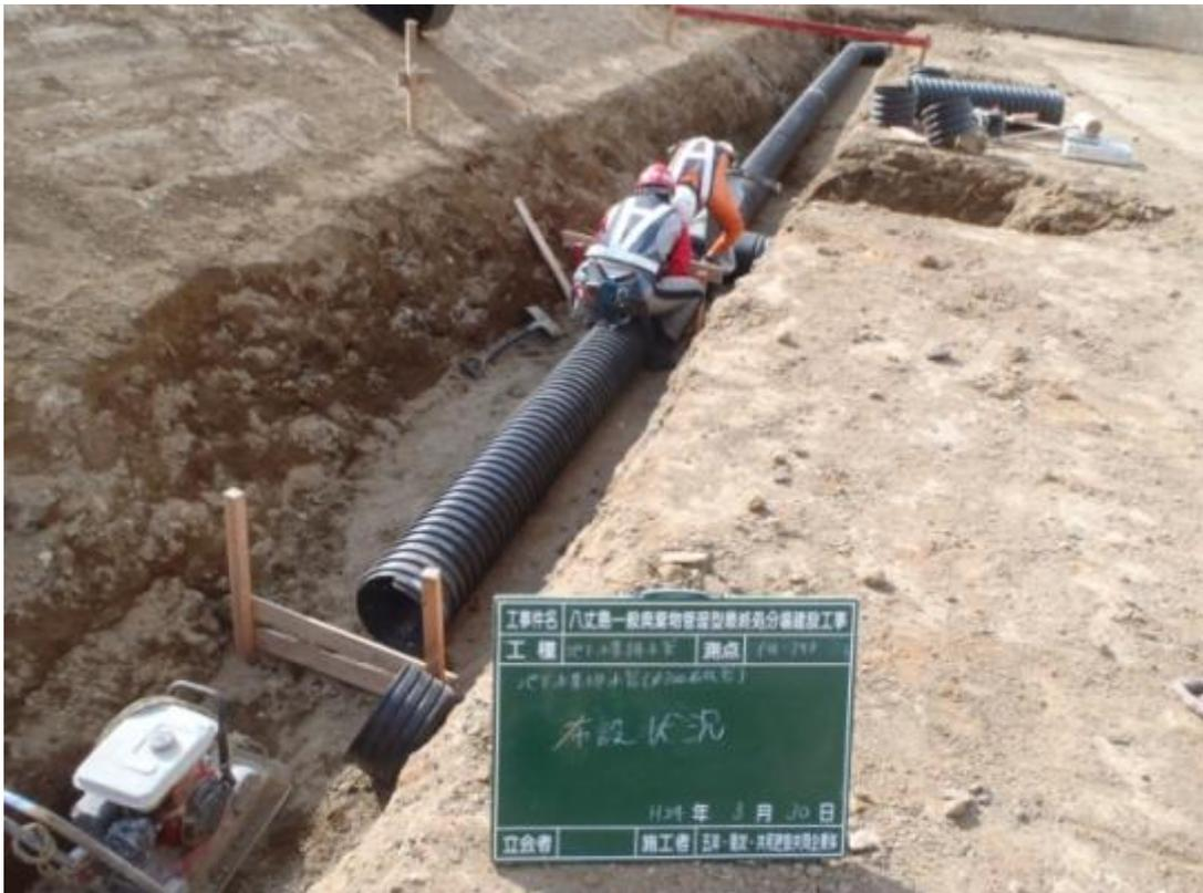
地下水集排水管 砕石による埋戻し状況
