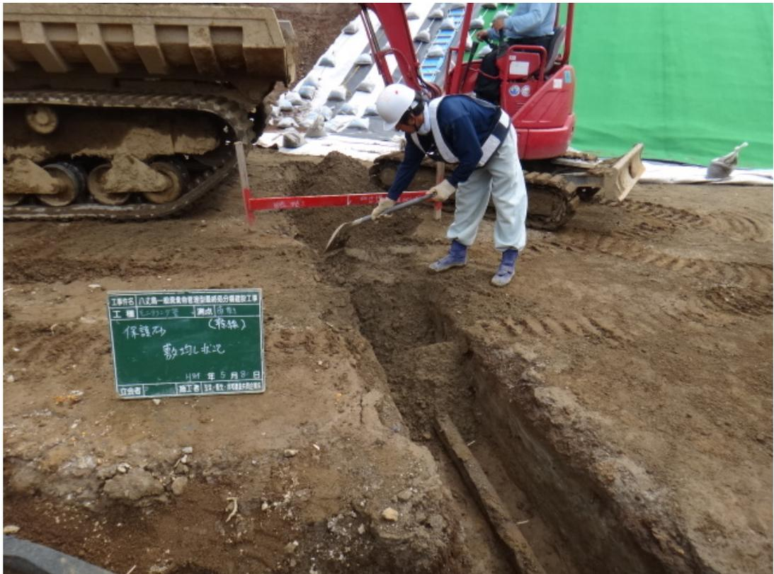
モニタリング専用管 埋戻し状況
