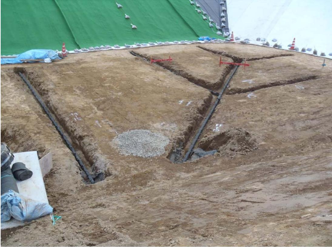
モニタリング専用管 保護砂による埋戻し状況
