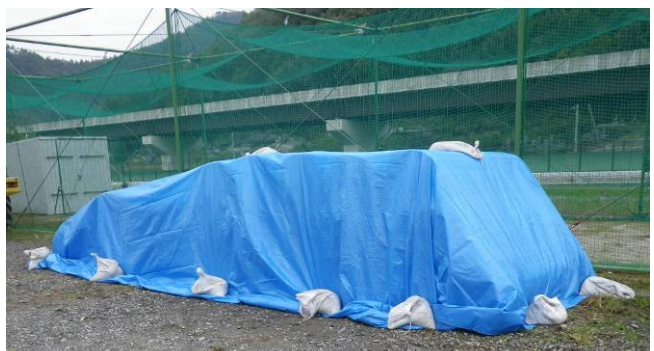
図 2-6 保護マット仮置き養生状況
