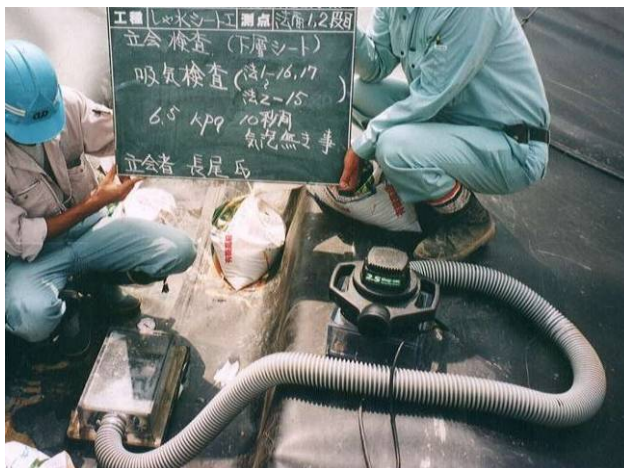
図 5-2 負圧検査状況
