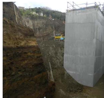
⑧埋め戻し 外側の防水塗装の後、埋め戻す。埋め戻しは厚さ30cmごとに転圧し、確実に締め固める。
