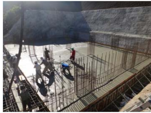
⑤コンクリート工 鉄筋、型枠を組み立て、コンクリートを打設する。
