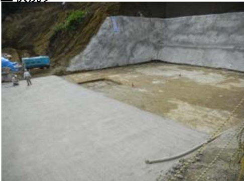
①基礎工事 地盤改良を行った後、基礎碎石を敷き均す。
